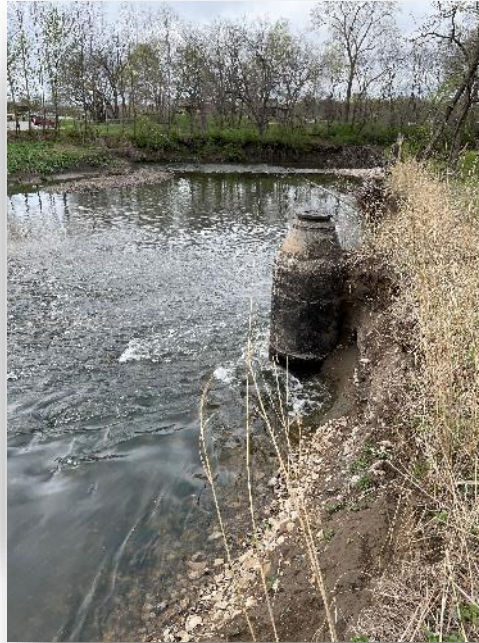
Site 43 - Tomahawk WWTP
